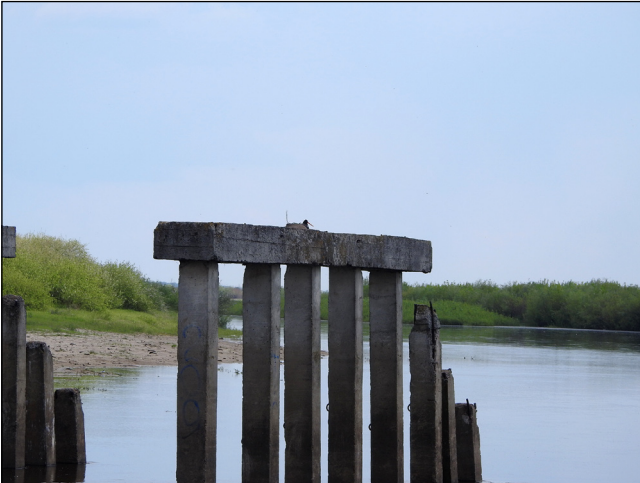
Фото 1. Гніздо кулика-сороки на залізобетонній конструкції зруйнованого мосту. 12.05.2019 р., с. Стрільськ Сарненського району. Тут і далі фото автора. Photo 1. A nest of the Oystercatcher on a ruinous bridge abutment.
