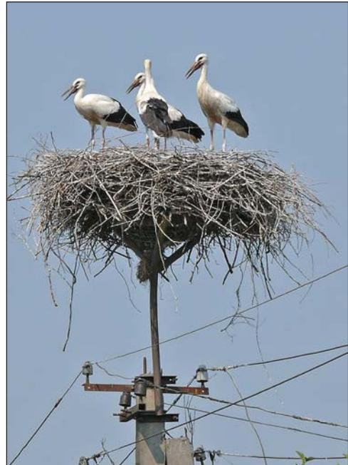
Фото 4. Платформа, поднимающая гнездо на столбе над проводами.
